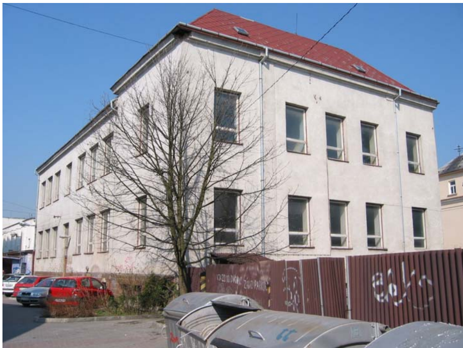
Súčasný stav budovy
