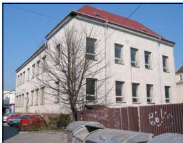
Súčasný stav budovy
